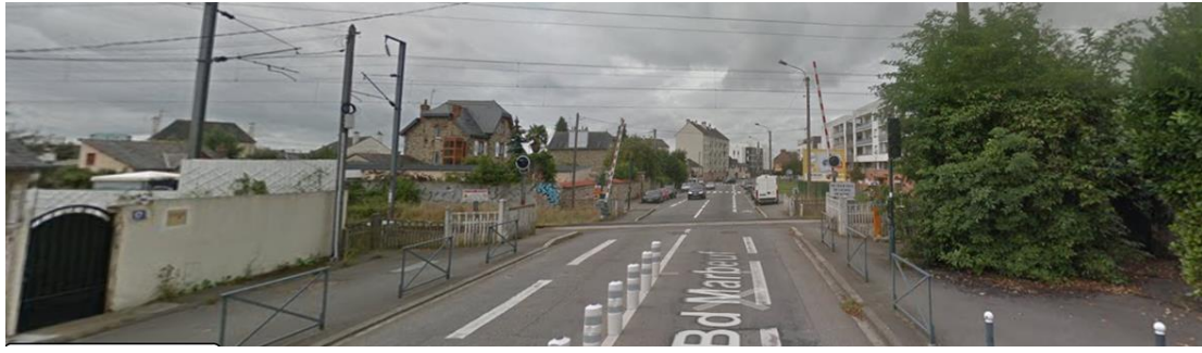
Vue sur le passage à niveau n° 193 avant travaux en 2018
