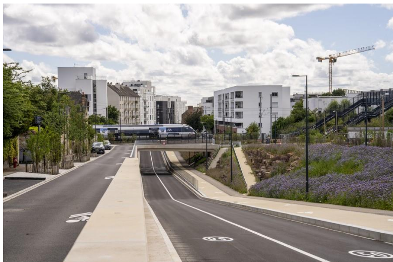
Trémie boulevard Marbeuf ouverte à la circulation avec de nouveaux aménagements - Arnaud Loubry Rennes Ville et Métropole
