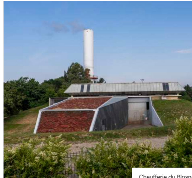
Chaufferie du Blosne
