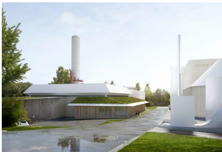
Future chaufferie du Blosne © AAGROUP / POLTRED
