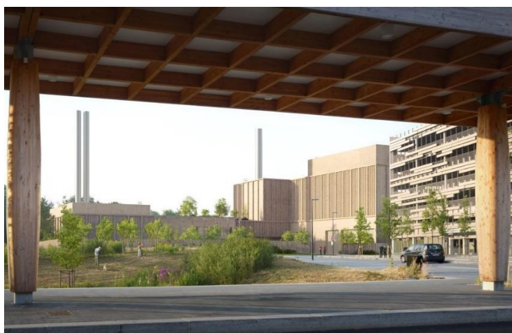
Future chaufferie de la Courrouze © AAGROUP / POLTRED
