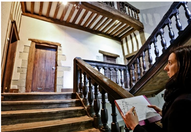
Diagnostic sur l'état du bâti © Ville de Rennes
